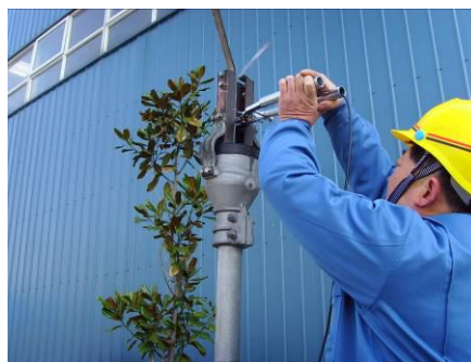
第三步 测量触指压力(未挂静触头)
