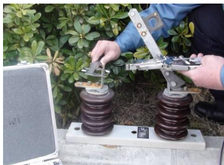
第一步 测量触头的宽度 a
